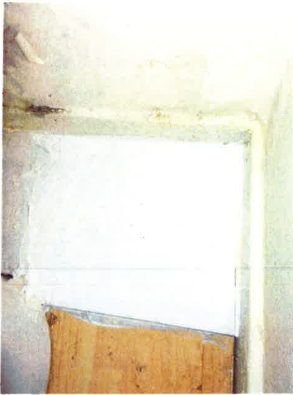
1. (d) Bathroom floor at toilet
