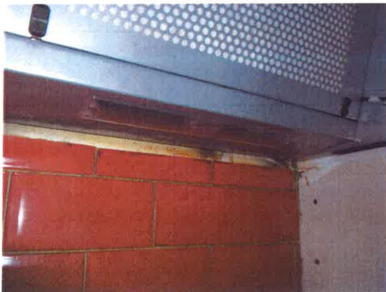
12. Replacement extractor hood fan
