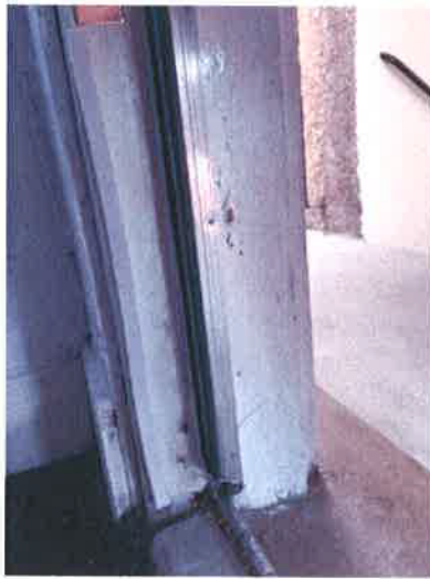
Front door frame
